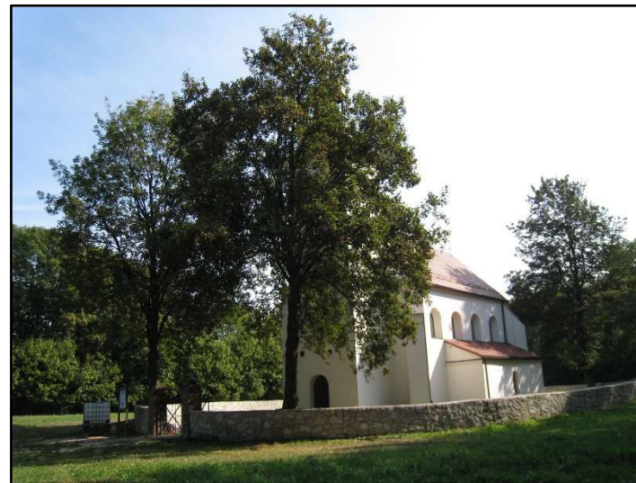
Fot. 3 Kościół na szczycie Dorotki
