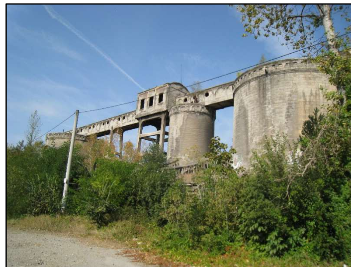
Fot. 12 Pozostałości dawnej cementowni Grodziec
