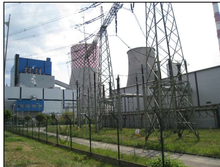
Fot. 31 Elektrownia Łągisza
