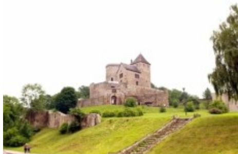
Zamek przed rekonstrukcją
