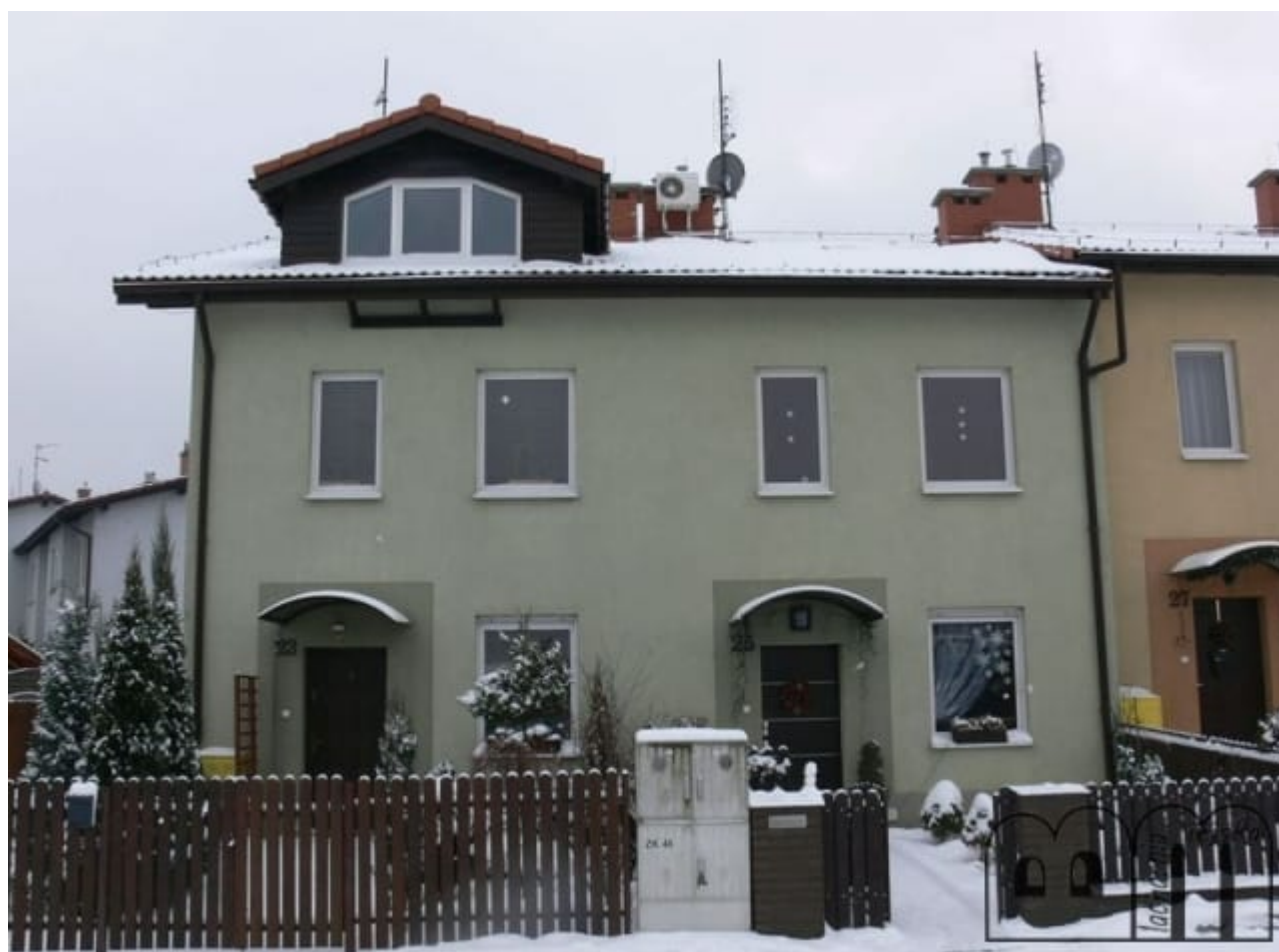
Widok na lukarnę od frontu - stan wykończeniowy.
