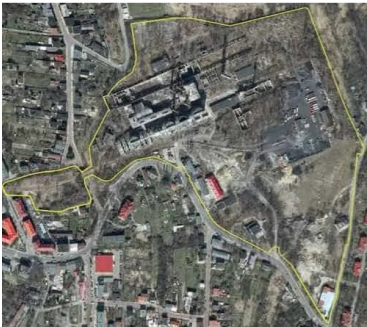
Teren byłej cementowni Grodziec.
