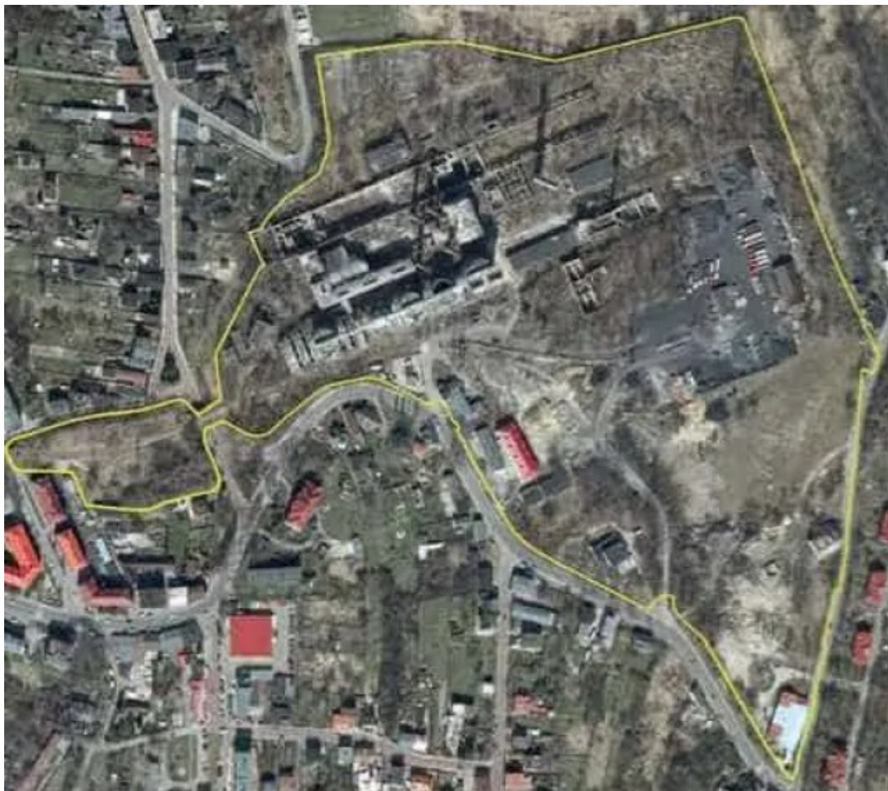
Teren byłej cementowni Grodziec.
